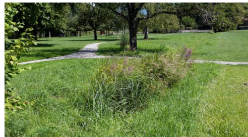
Ouvrage végétalisé de gestion des eaux pluviales
